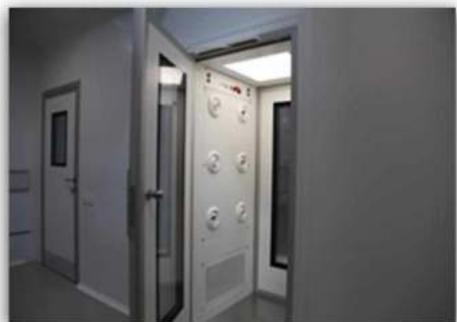
При проходе персонала через шлюз в чистое помещение, пыль сдувается мощным потоком чистого воздуха. Поступающий во внутреннюю камеру
