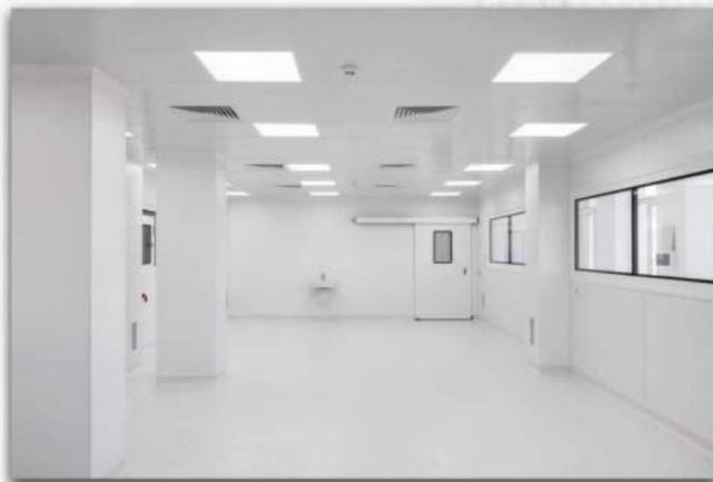
Заказчика в 2/3 территории помещения лаборатории чистота воздуха должна быть не менее ISO 6 (P 10 000), а в 1/3 – не менее ISO 5 (P 1000). Техническое решение поставленной задачи было достигнуто путем применения герметичных дверей HPL, герметичных ограждающих конструкций HPL, приточно-вытяжной установки гигиенического исполнения с пакетом автоматики и климат-контроля, ламинарного потолка 3000x2400 с очисткой воздуха HEPA H14 и приточными воздуховодами с HEPA H13.
